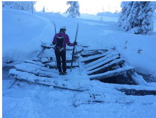
Broa ved Drangane kollapset januar 2016
